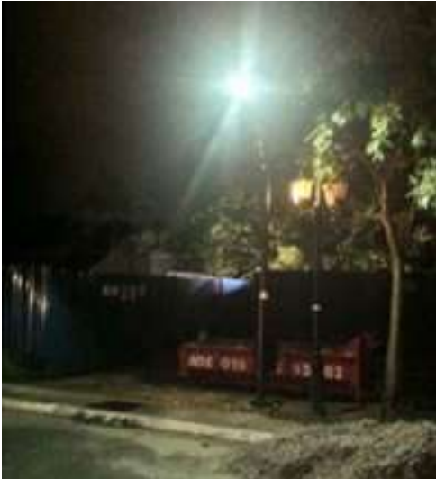
30w Solar LED Masjid Wilayah KL, JKR KL
